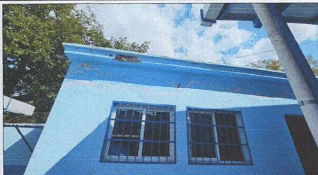
Foto 2: IMPERMIABILIZACION, RESANADO Y PINTURA DE PAREDES EN BODEGA
